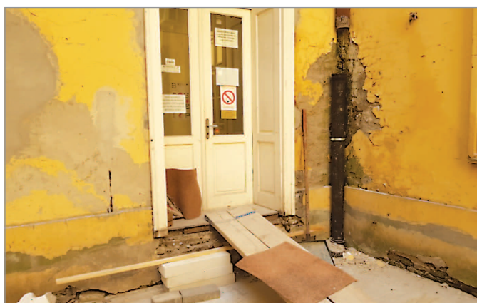
7. ábra. Az MTTK udvari bejárati ajtaja
