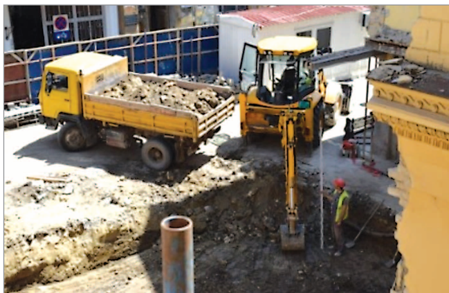
11. ábra. A felesleges törmelékanyag, illetve föld elszállítása az egyetem udvaráról
